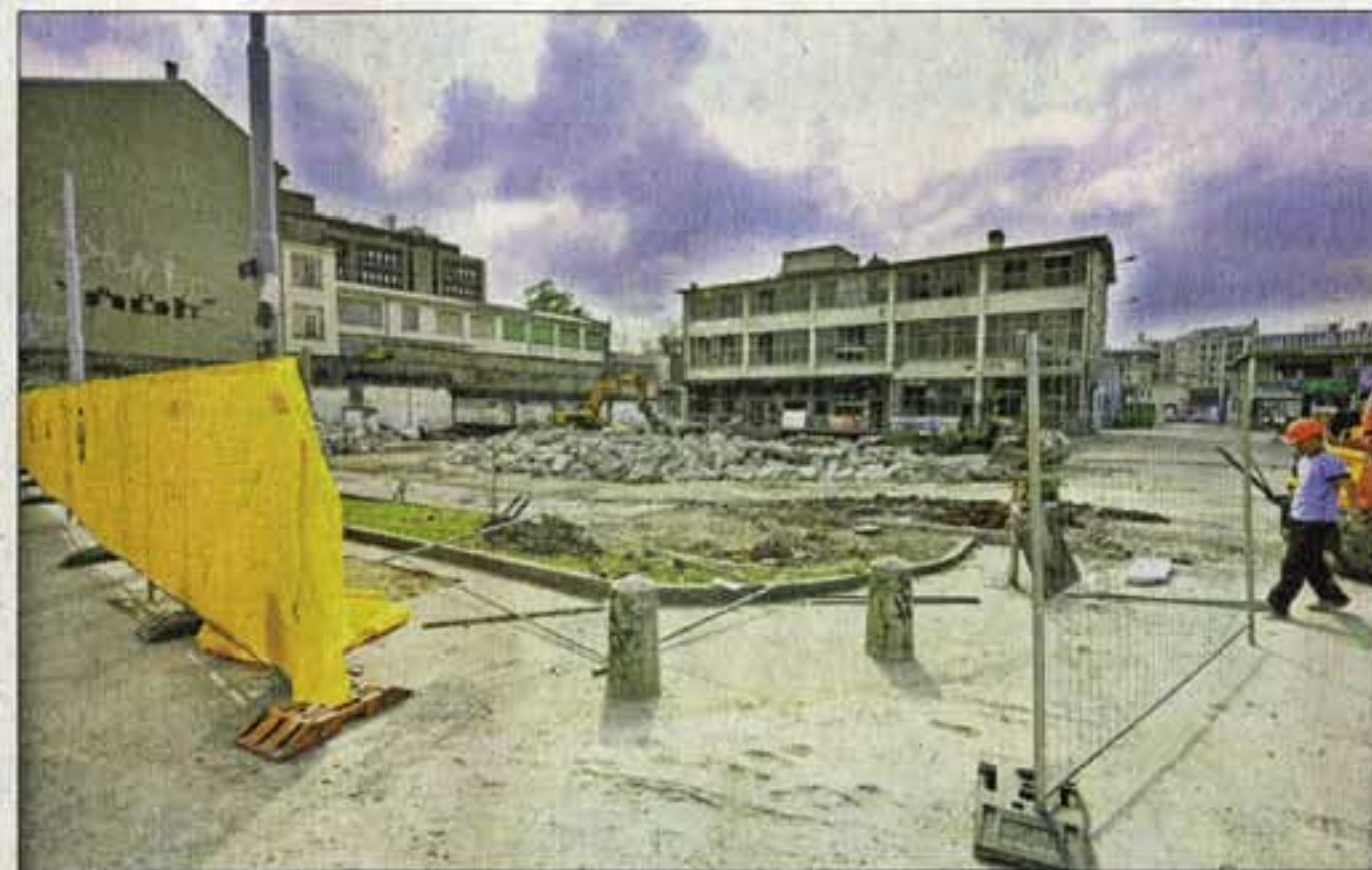
Bâtiments rasés. La démolition se poursuivra côté boulevard de Saint-Georges jusqu'à la fin mai. (LAURENT GUIRAUD)
