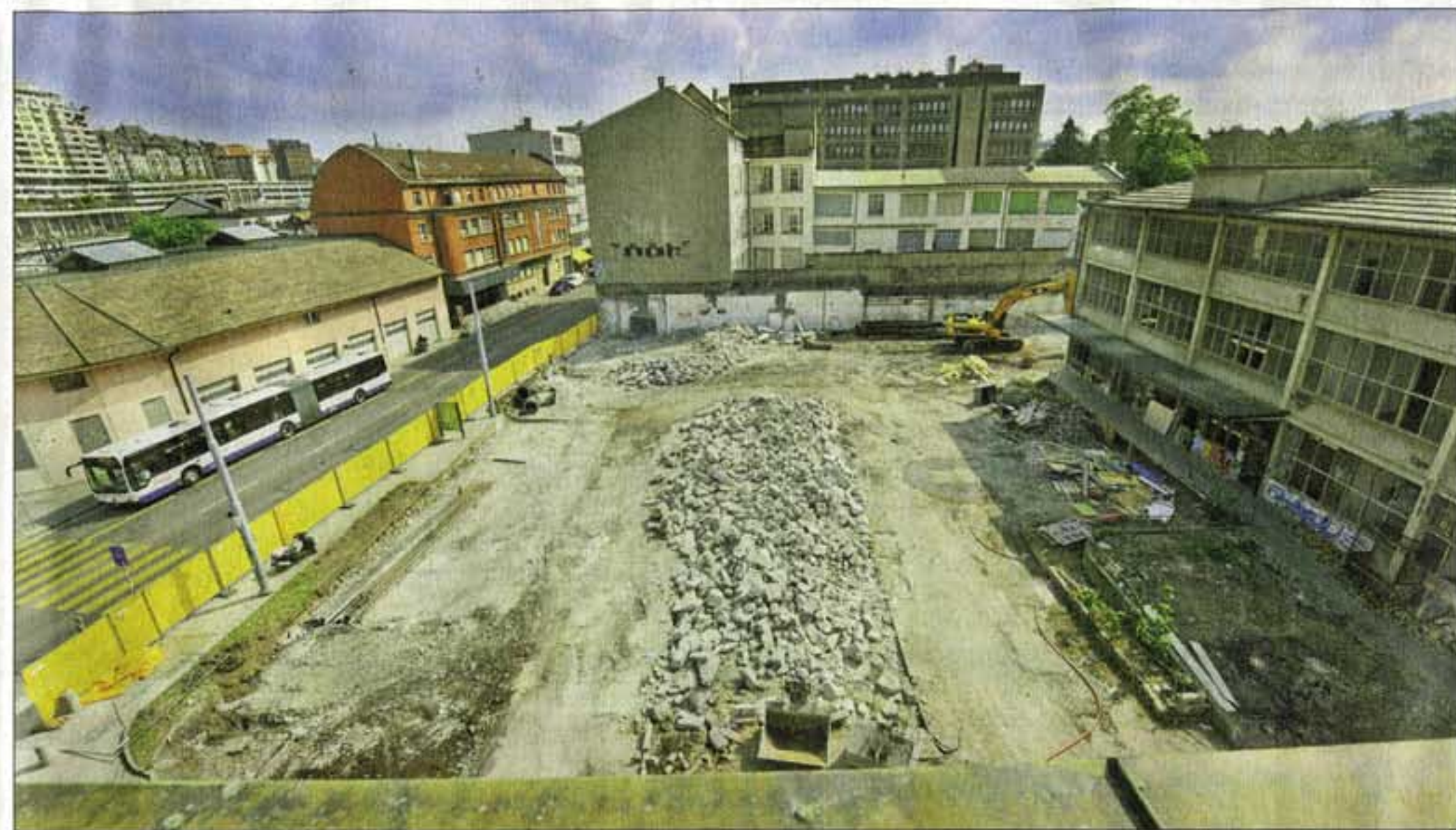
Vue aérienne du site. Côté quai du Rhône, plusieurs bâtiments ont déjà été détruits. A terme, tous les locaux seront rasés pour permettre la dépollution du sous-sol. (LAURENT GUIRAUD)
