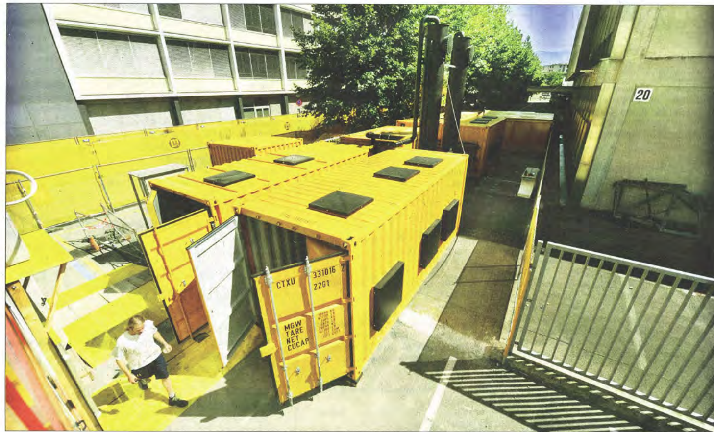
Pompage de l'eau de la nappe phréatique. L'eau est séparée des polluants puis filtrée à plusieurs reprises. (LAURENT GUIRAUD)
