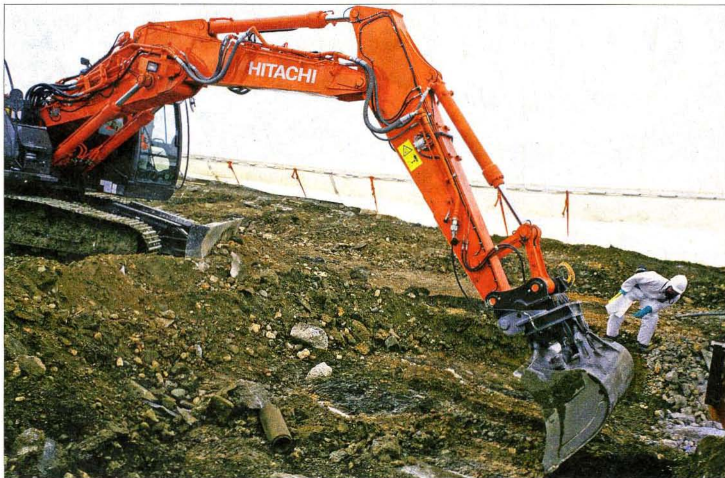
Chantier confiné de décontamination à Artamis. Une pelle mécanique à cabine hermétique extrait la terre polluée. (PASCAL FRAUTSCHI)
